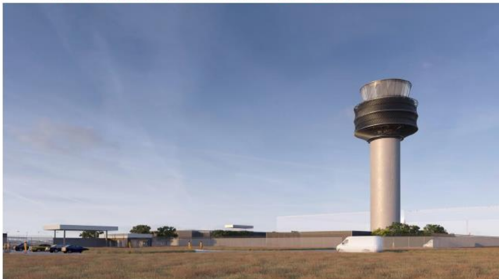
Figura 1: Imagen de la torre de control de tráfico aéreo y edificios auxiliares
