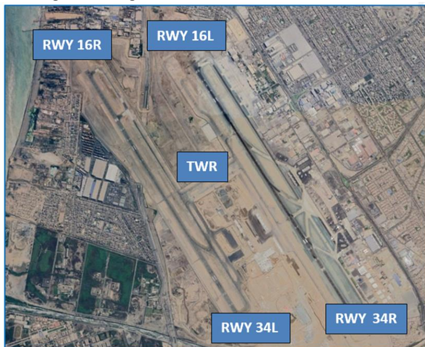
Imagen general del aeropuerto y de la ubicación de la TWR
